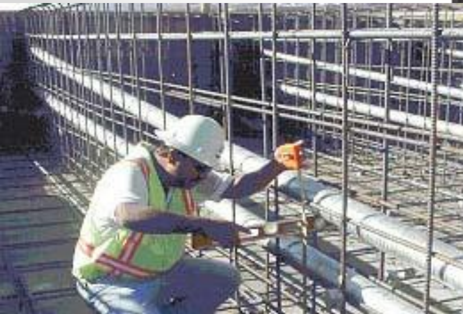
Provjera položaja cijevi – rebraste z.c.
